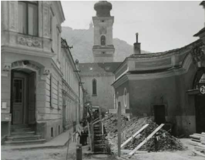
Mit dem Kanalbau bei der Volksschule wurde im Frühjahr 1968 begonnen.
